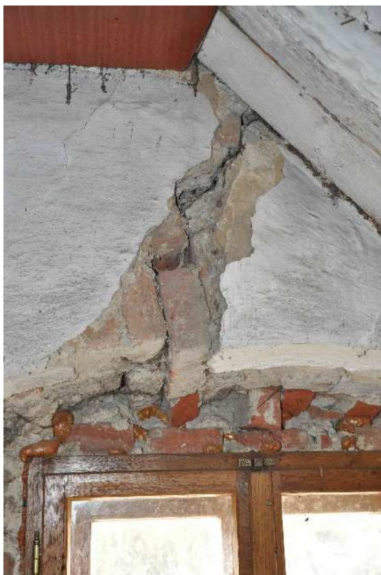
12 trhlinou a poklesem cihel narušený nadokenní záklenek na vnitřní straně severního okna v západní štítové stěně, trhliny na venkovním líci stěny okolo okna
