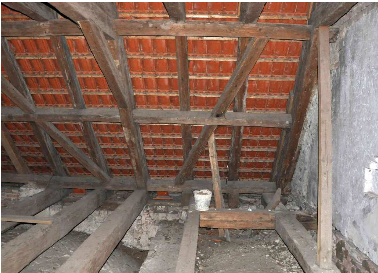
22,23 spodní část původní krokve jalové vazby vyříznuta, konec nad mezilehlou vaznicí ukotven k vaznici dvojicí kramlí, krokv nahrazena nově vloženou krátkou krokví vedle, uloženou na mezilehlou vaznici a novou část pozednice, původní vazný trám vyjmut v celé délce bez náhrady
